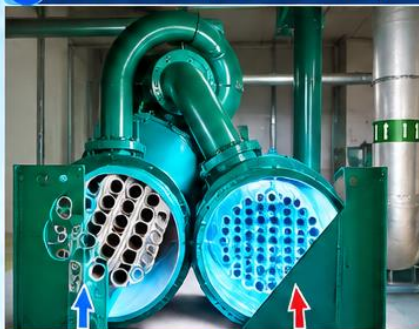
2 Inside a Chiller (Tube Bundle View)
